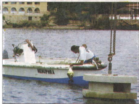
Un chemin a été aménagé sous le parapet de la digue pour qu'une grue puisse venir déposer les récifs. A droite, l'immersion d'un plateau hexagonal. (Photos Franz Chavaroche)
